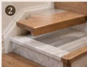
2 Τοποθέτηση ημιμασίφ πατημάτων και ριχτιών
